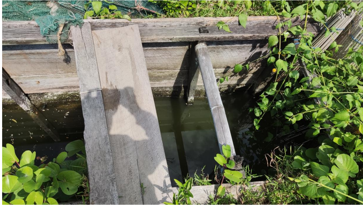
Kondisi Pintu Air
